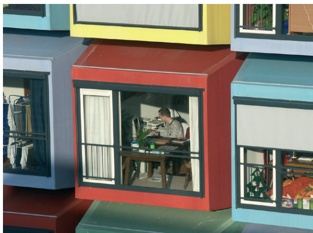
La casa dello studente progettata e realizzata a Utrecht (2004) dallo studio De Vijf, utilizzando cellule spaziali componibili di diversi colori
